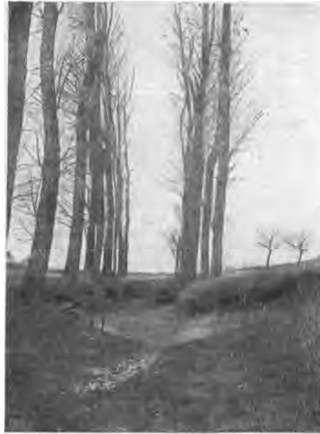
FIG. 106. — Affouillement produit par les eaux.
