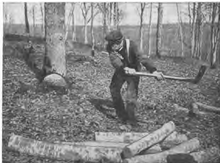
2 e mouvement : Coup de hache horizontal destiné à faire sauter l'éclat.
