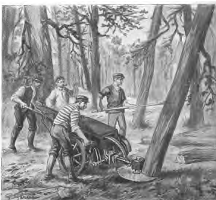
FIG. 8. — Scie mécanique « La Bücheronne » dans la position d'abatage. Cette scie est mise en mouvement par un moteur électrique.
