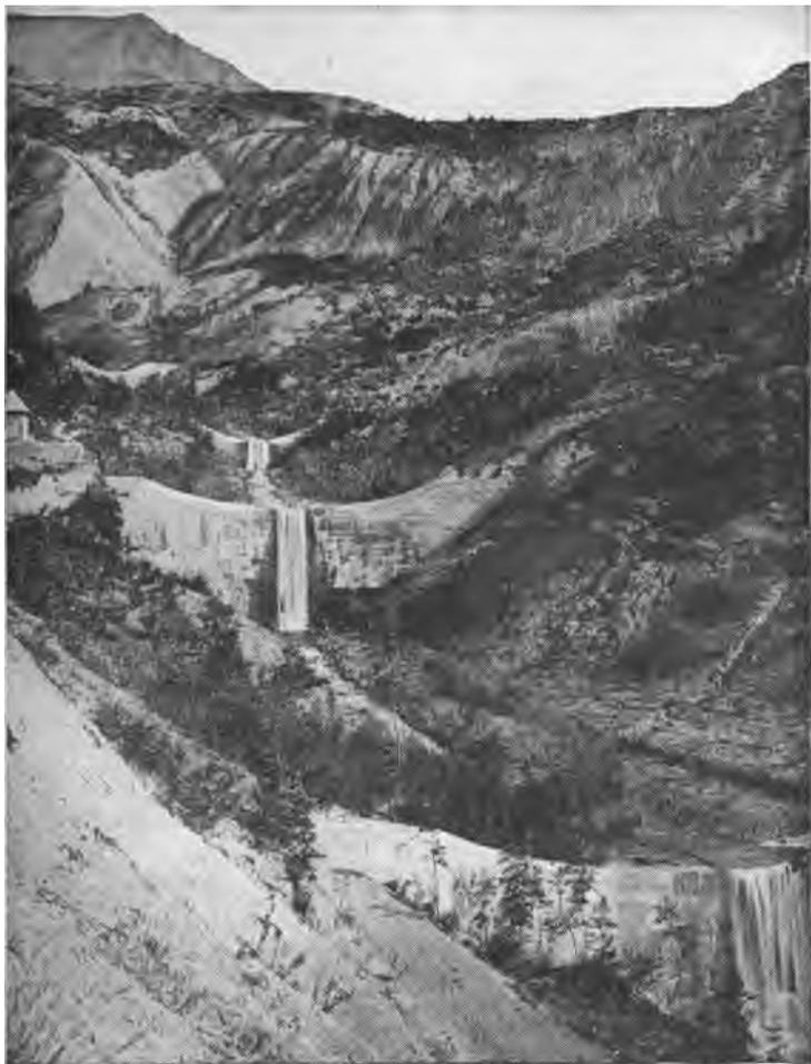
FIG. 482. — Succession de barrages en maçonnerie réglant le débit d'un torrent, afin d'éviter les ravinelements.
