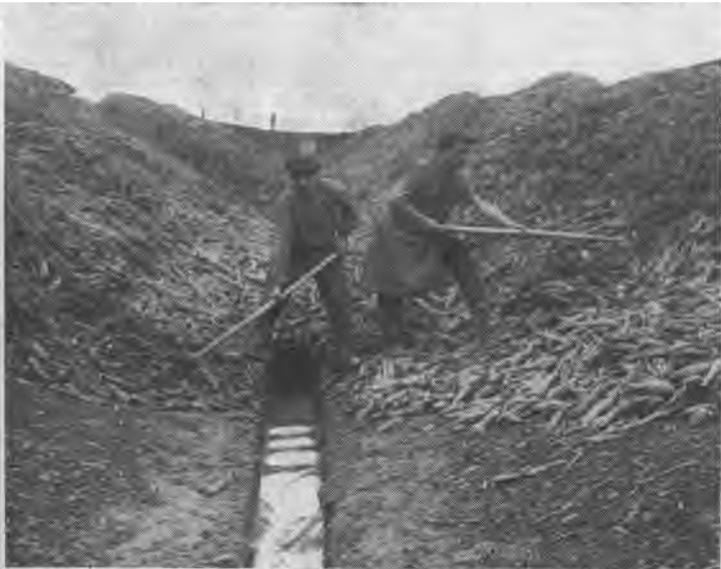
FIG. 553. — Caniveau d'entraînement ou transporteur hydraulique de betteraves.
