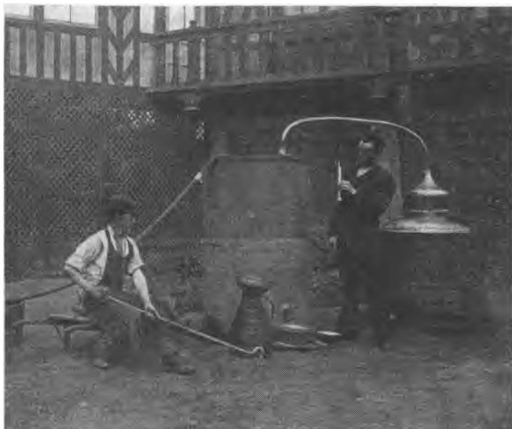
FIG. 648. — Alambic simple chez un bouilleur de cru.
