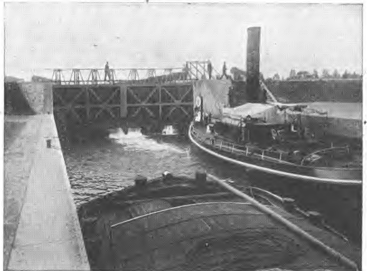
FIG. 783. — Vue d'une écluse au moment où le u sas se remplit d'eau.
