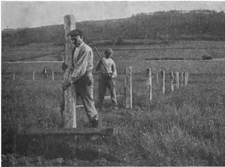
FIG. 1187. — Mise en place d'un poteau d'angle avec barre transversale.
