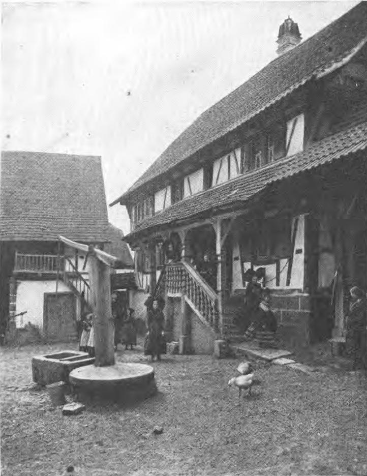
FIG. 1279. — Maison alsacienne comportant un rez-de-chaussée surélevé protégé par un avant-toit, et un premier étage formant grenier. L'escalier qui donne accès au rez-de-chaussée est pourvu d'une rampe en bois ouvrage.
