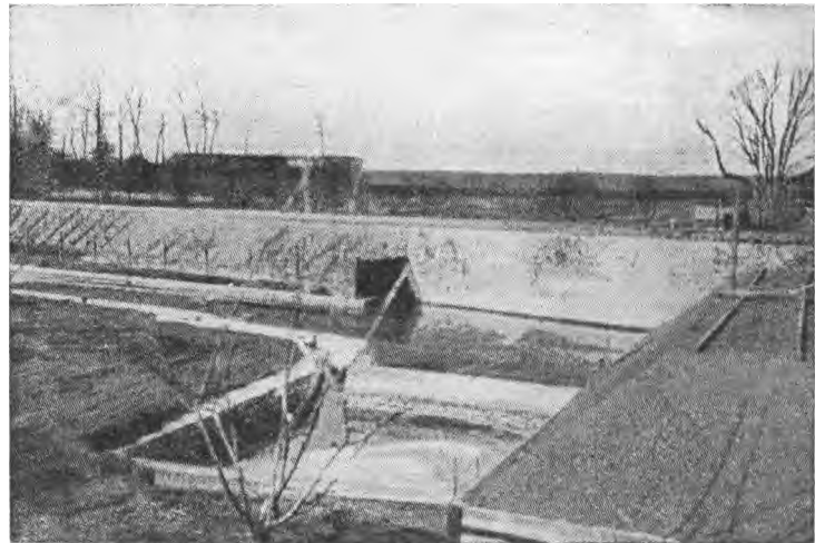
FIG. 1674. — Canal de décantation et puisard d'aspiration pour des eaux résiduaires.
