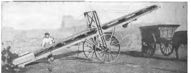
FIG. 1833. — Transporteur-élévateur. Prise au tas et chargement sur tombeau.
