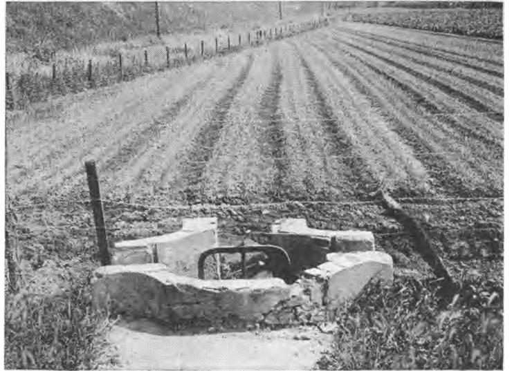
FIG. 1912. — Champ d'épandage pour eaux d'égout à Gennevilliers (Seine) Au premier plan se trouve la vanne d'arrivée des eaux d'égout.
