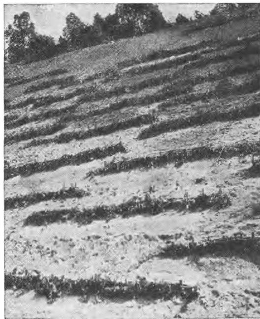
FIG. 2051. — Fascines fixant un talus pour éviter les éboulements.
