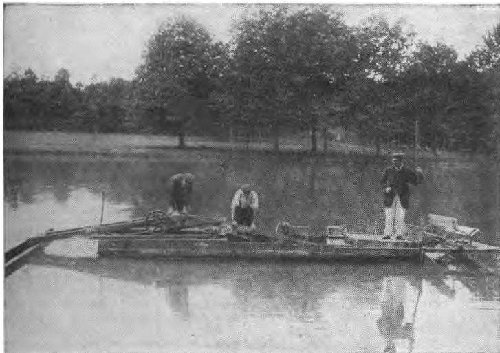
FIG. 2053. — Montage de la faucheuse à l'arrière du bateau.
