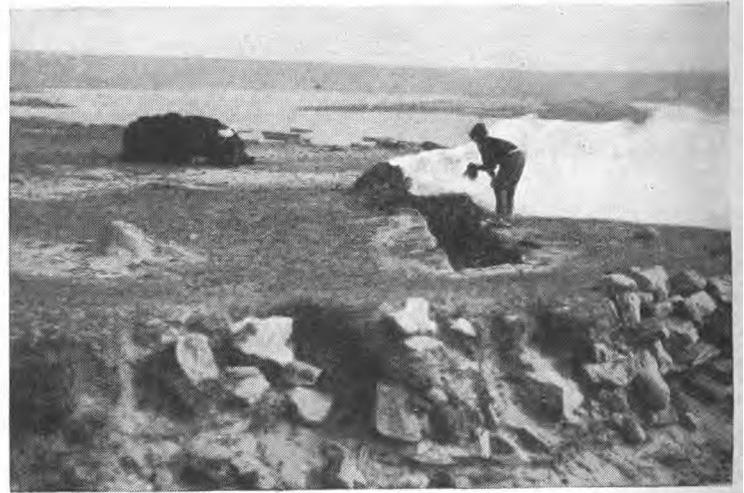
FIG. 2464. — Calcination du goémon sec dans un four en tranchée.
