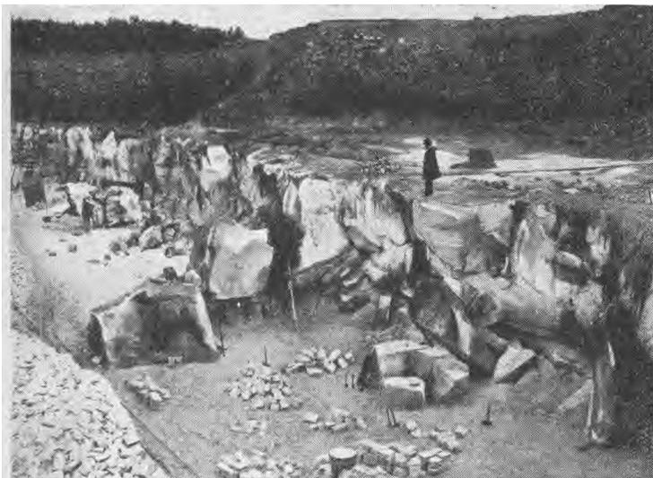
FIG. 2533. — Exploitation d'une carrière de grès. Abatage d'un banc pour le façonnage des pavés.
