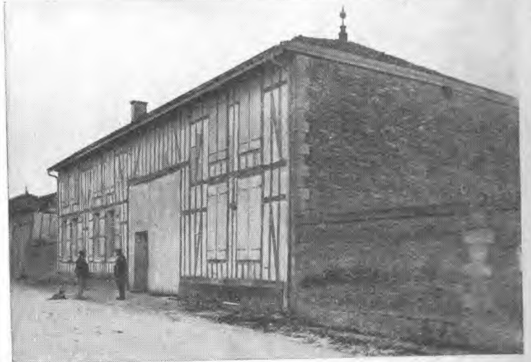
2. — Habitation champenoise en pans de bois et torchis, entrée charretière, chambre au premier étage, en façade sur rue, grenier sur cour.
