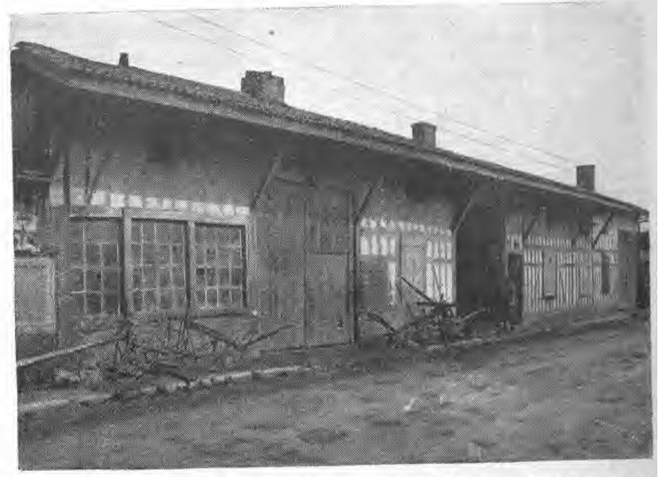
4. — Habitation de maréchal ferrant, en Champagne. Atelier et maison d'habitation. Avant-toit sous lequel on place les instruments aratoires en réparation et où l'on ferre les chevaux.
