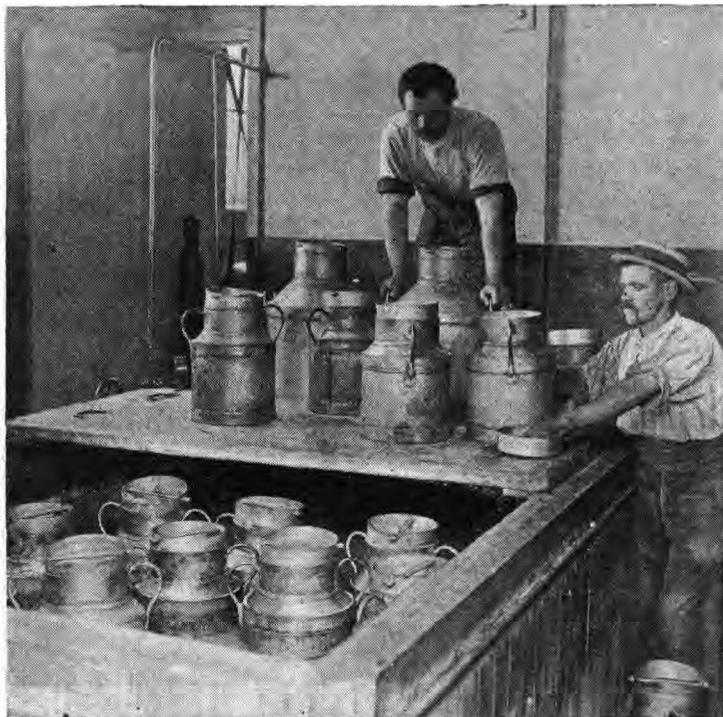
FIG. 213. — Refroidissement du lait avant son expédition : on plonge les brocs dans un bassin alimenté continuellement d'eau fraîche.
