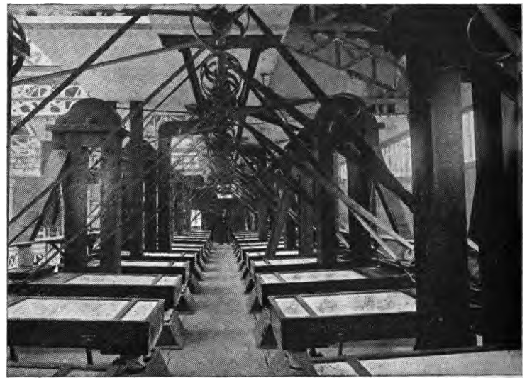
FIG. 544. — Vue d'une batterie de blutoirs horizontaux.
