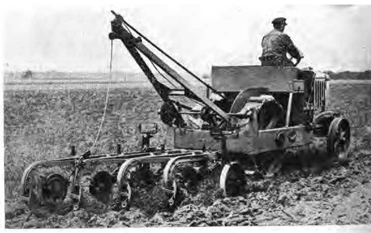
6. — Tracteur Tourand-Latil avec dispositif de relevage de la charrue.
