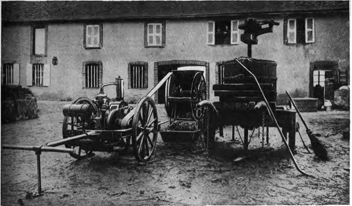
FIG. 636. -- Broyeur de pommes actionné par un moteur à pétrole de Dion.
