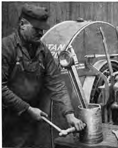
FIG. 621. — Démontage d'une bielle.
