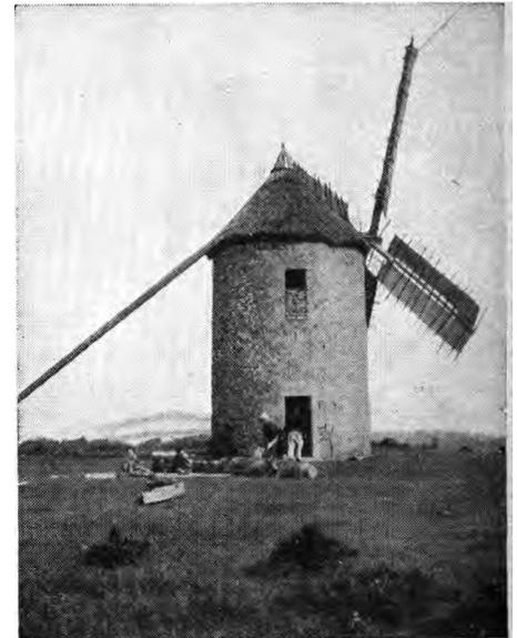
FIG. 664. — Moulin à vent à ailes et toit mobiles.
