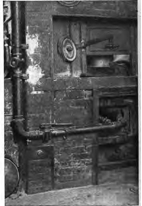
3. — Chauffage au gaz, système Cryptos.
