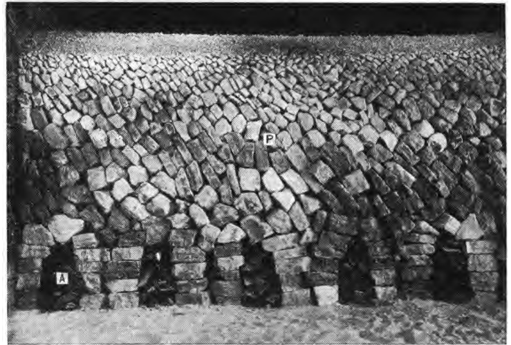
FIG. 1190. — Four à plâtre avant l'allumage.
