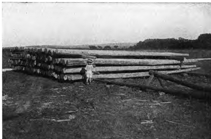
FIG. 1305. — Poteaux télégraphiques préparés et injectés au sulfate de cuivre sur un chantier de séchage.
