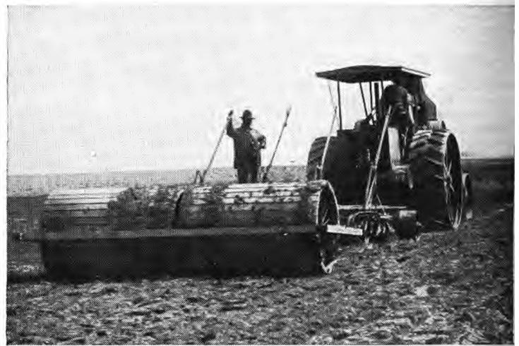
2. Rouleau à battes (traction mécanique).
