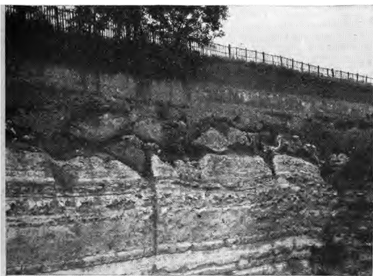
FIG. 1856. — Sous-sol détruit par les eaux d'infiltration.
