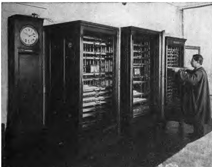
FIG. 1758. — Etuve Schribaux pour étudier la faculté germinative des graines avec régulateur de température commandé par une horloge.
