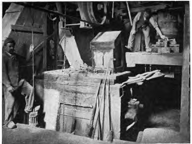
FIG. 1926. — Opération du malaxage.
