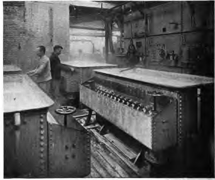
8. — Filtration, dans des filtres mécaniques, des jus épurés.
