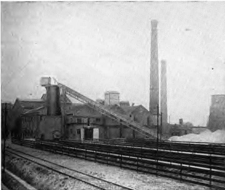
3. — Sucrierie (vue extérieure). Silos à betteraves. Transporteur hydraulique. Élévateur pour la pierre à chaux. Four à chaux, etc.
