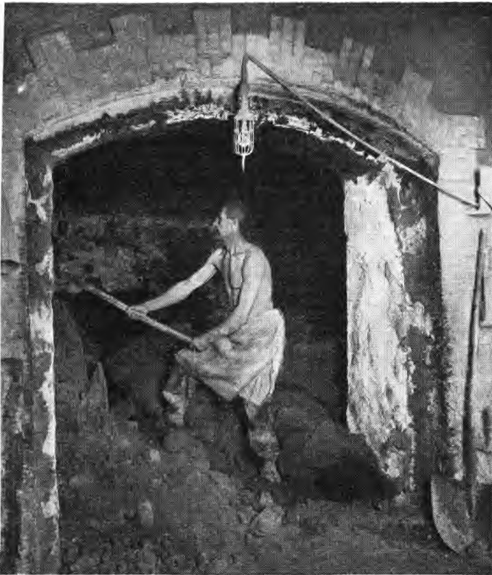
FIG. 1927. — Décuvage de la chambre aux superphosphates.
