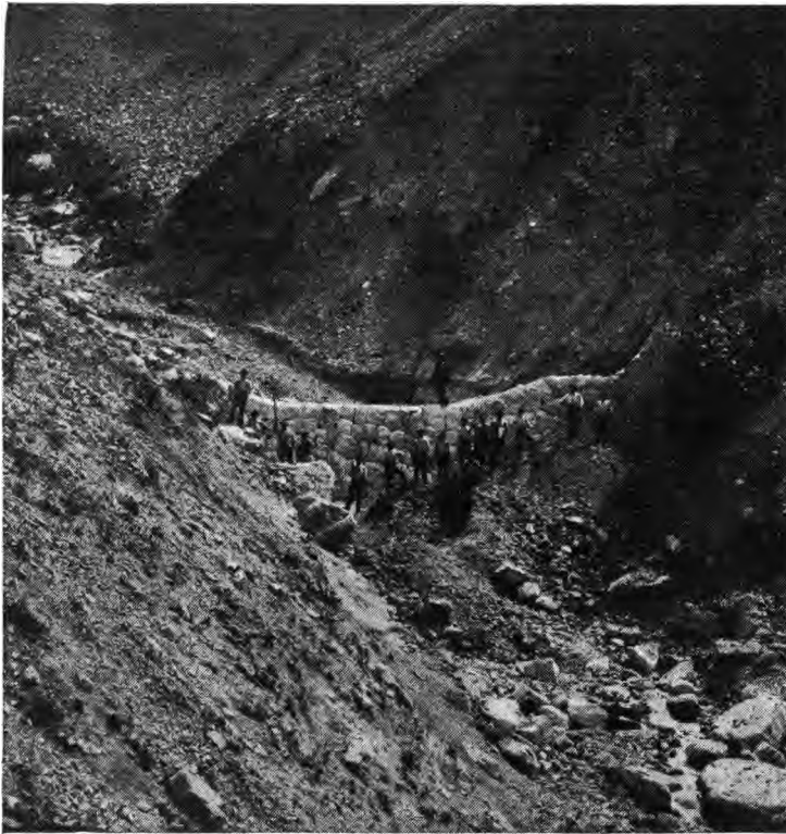
FIG. 2136. — Barrage d'un torrent, en voie de construction.
